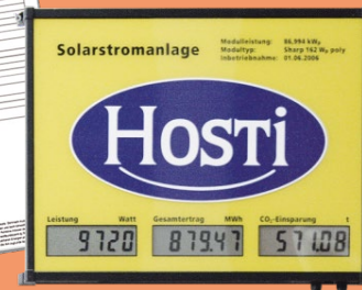
Photovoltaikanlage auf dem Hausdach in Pfedelbach
